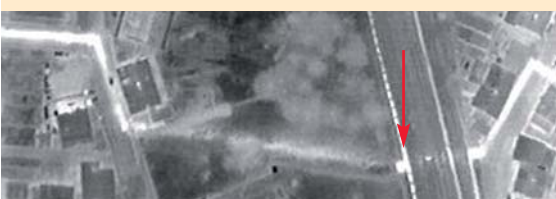
Image thermique : Pipeline avec emplacement supposés de fuites.
