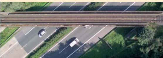
Pont de chemin de fer surmontant une autoroute, orthophotographie...
